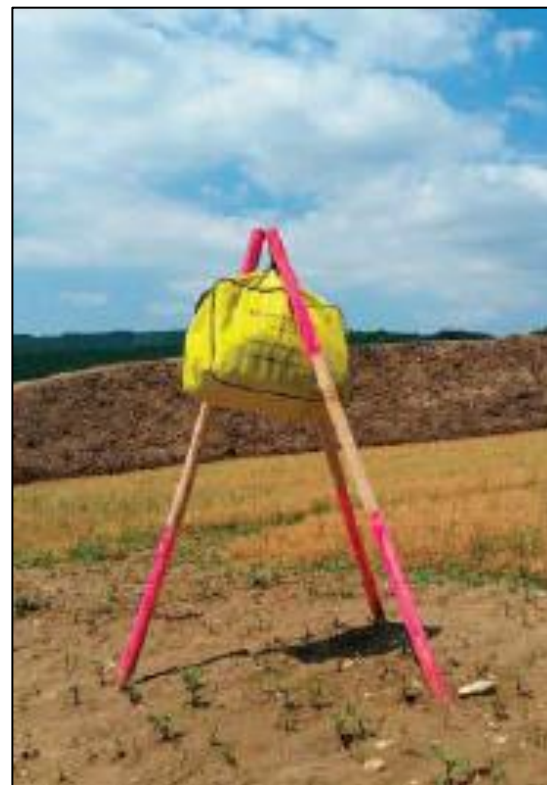
Figure 66 : Exemple de kit anti-pollution isolé du sol (Guide technique "Protection des milieux aquatiques en phase chantier", AFB, 2018)
